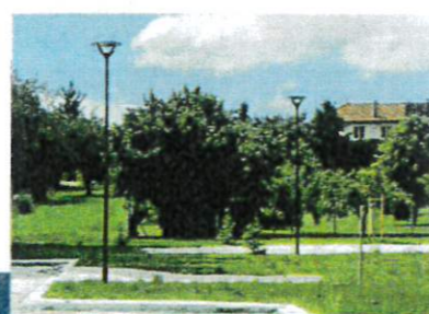
Maintenance et travaux d'éclairage public
