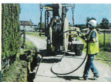
Contrôle et aménagement des réseaux d'électricité et de gaz
